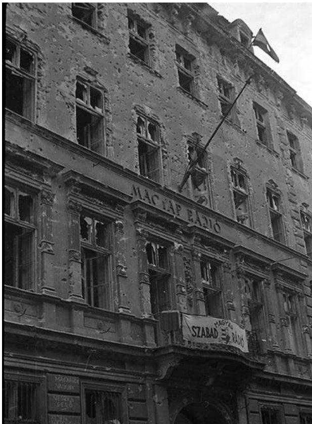
A Bródy épület 1956-ban
